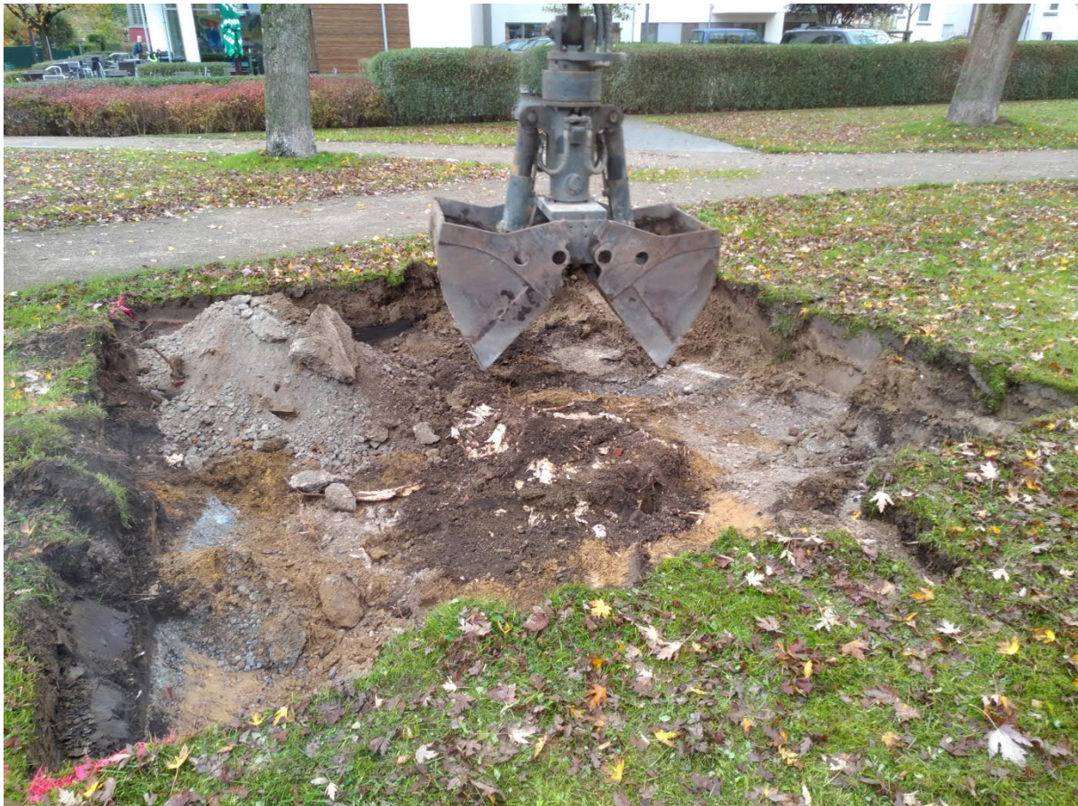
Abb. 23: Baumbetausbesserung mit deutlicher Schottersohle ab 60cm Tiefe (Gabriel Volk, Stadt Essen, 2020)
